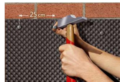
**3.** FONDALINE® pode ser diretamente pregada ao betão, apenas em níveis em que não existe risco de infiltração de humidade ou águas do subsolo. No topo, deverá ser utilizado o perfil de remate Fondaline
