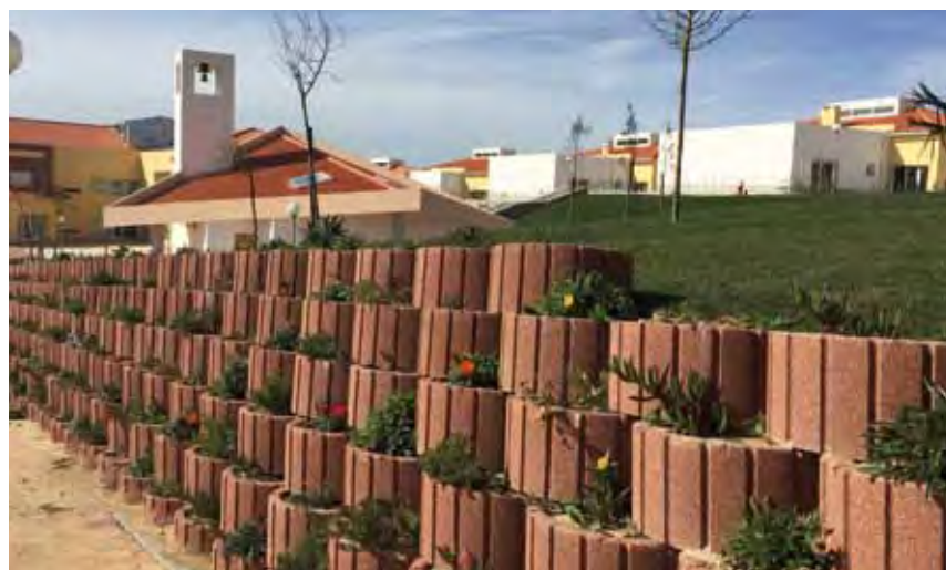
Bordeaux - Residencial Sênior - Arruda dos Vinhos
