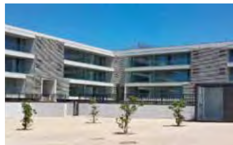
Edifício Portus Cale - Vila Nova de Gaia
