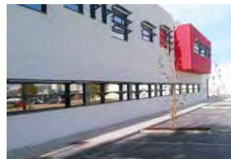
Edifício CDRSP Marinha Grande
