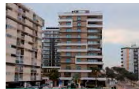
Edifício praia da Rocha
